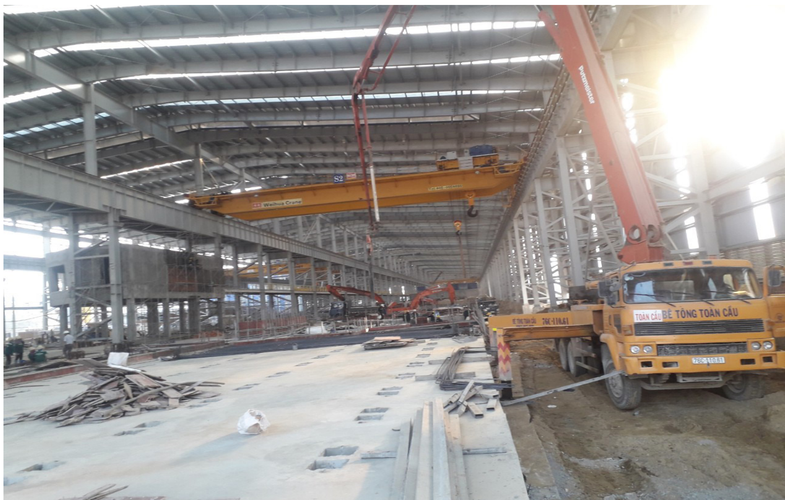
Công trình Móng Kho than
