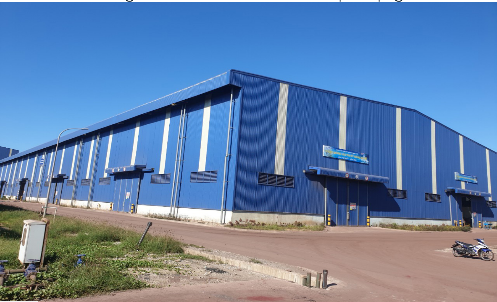
Công trình Nhà sửa chữa Thiết bị di động
