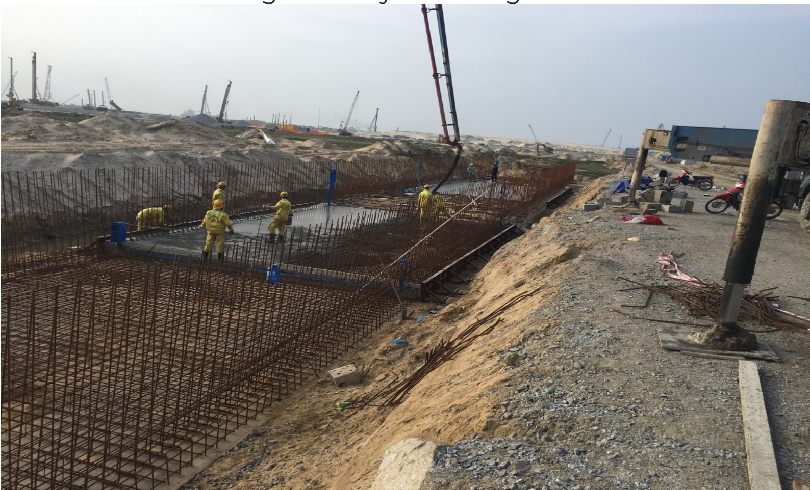
Công trình Móng tường chắn bụi
