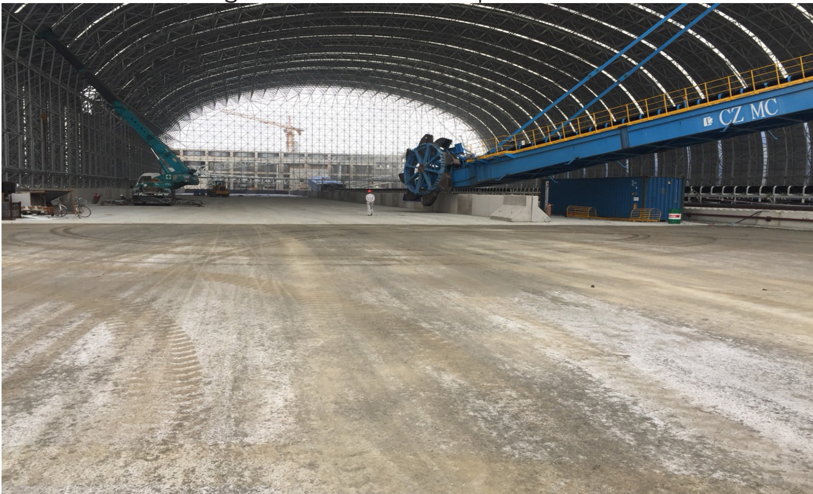
Công trình Nền bãi sơ cấp kho vôi viên
